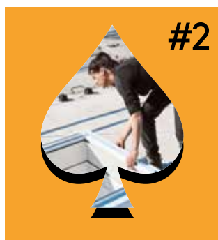
Installation des Montagerahmens
