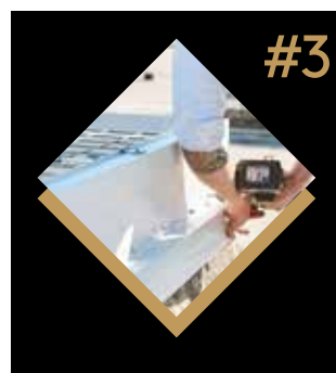
Montage des Aufstockers
