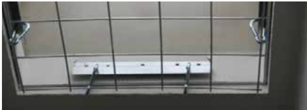
Auffangsicherung LK-K RSM an Karabinerhaken befestigt in bauseitiger Auswechslung
