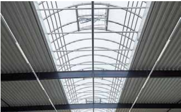
Lichtband LB plus mit Firstklappen, NRWG F6 LB, Ab- und Durchsturzsicherung EAD und Integrierte Durchsturzsicherung ID 1200 plus – Ansicht von unten
