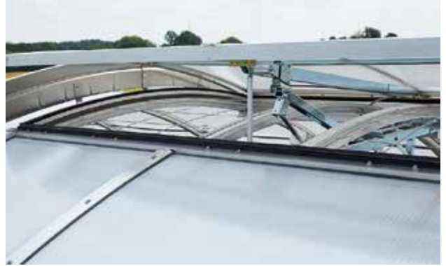
Lichtband LB plus mit Firstklappe und Lüftungsantrieb zur Be- und Entlüftung sowie NRWG F6 für den Rauch- und Wärmeabzug
