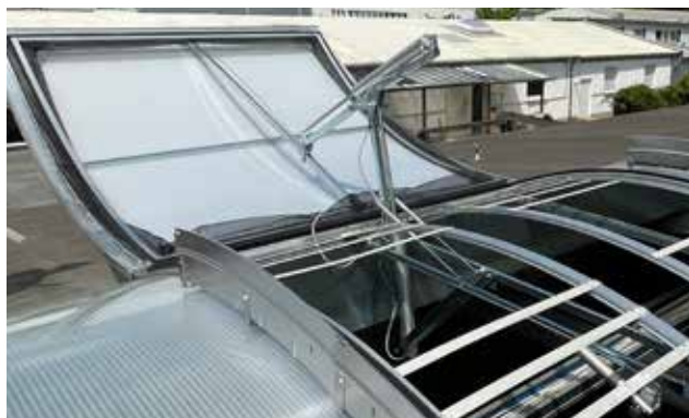
Kingspan ESSMANN MosquitoMesh für Lichtbänder — nach Auslösung des NRWG
