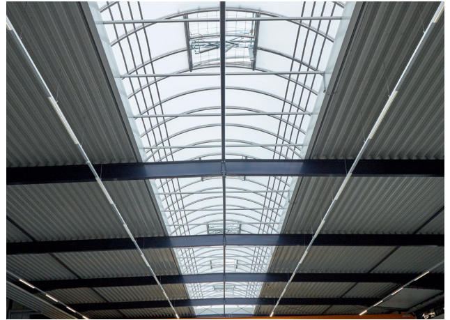
Lichtband LB plus mit integrierter Durchsturzsicherung ID1200 plus und 1,50 x 2,00 m Firstklappe – Ansicht von unten
