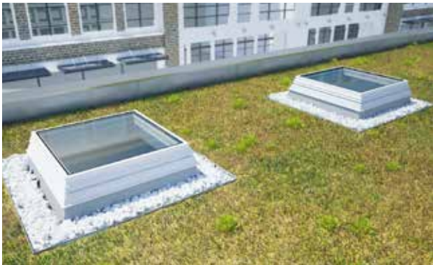
Einbaubeispiel: Flachdachfenster FDF im Gründach
