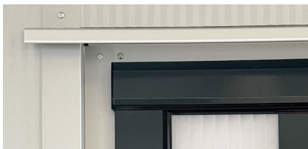
Abgedichtete Ecke oben
