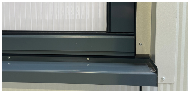
Abgedichtete Ecke unten
